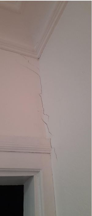
Fissures aux murs dans plusieurs pièces
