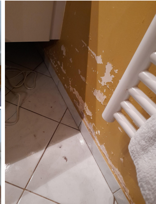
Problèmes d'humidité et de fissures dans la salle de bain à cause des façades pan de bois dégradées
