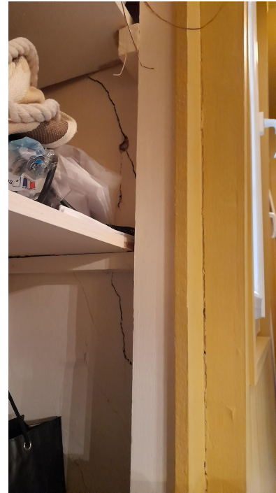
Problèmes d'humidité et de fissures dans la salle de bain à cause des façades pan de bois dégradées
