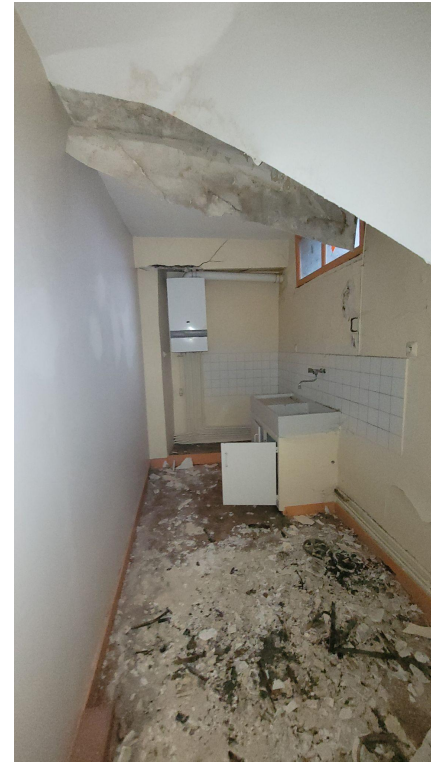
Logement T3 à gauche des escaliers avec effondrement d'une partie de plafond donnant sur greniers communs et présence forte d'humidité
