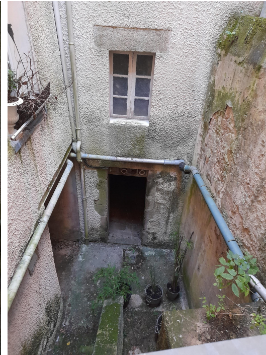
Façades sur cour (pan de bois) : reprise complète des enduits, remplissages et structure pan de bois + menuiseries + réseaux en façades
