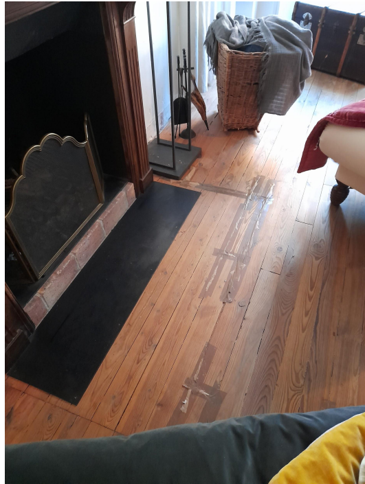
Défauts d'étanchéité du plancher et en pieds de murs suite aux mouvements de structure
