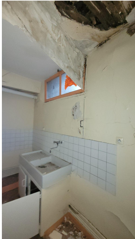
Logement T3 à gauche des escaliers avec effondrement d'une partie de plafond donnant sur greniers communs et présence forte d'humidité
