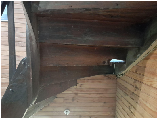
Escalier bois très attaqué par les vrillettes avec certaines contremarches trouées
