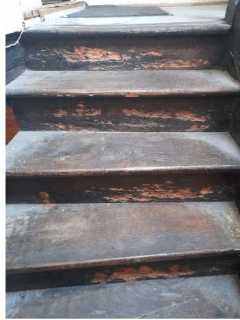
Escalier bois très attaqué par les vrillettes avec certaines contremarches trouées
