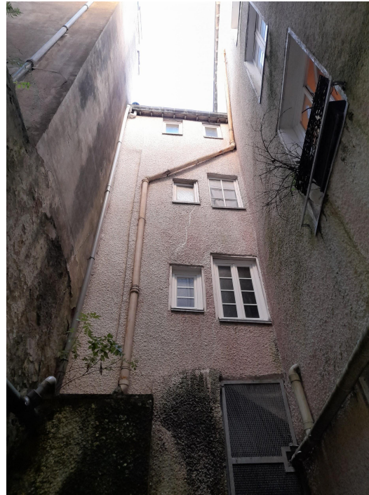
Façades sur cour (pan de bois) : reprise complète des enduits, remplissages et structure pan de bois + menuiseries + réseaux en façades
