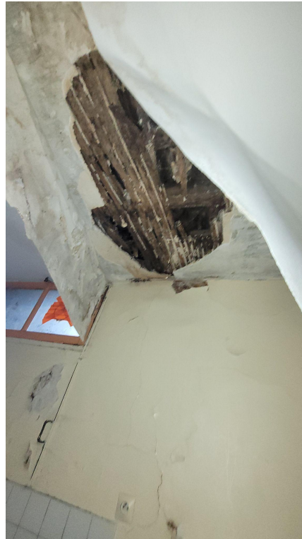
Logement T3 à gauche des escaliers avec effondrement d'une partie de plafond donnant sur greniers communs et présence forte d'humidité
