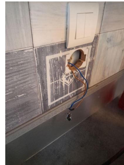
Défauts électriques - prise qui a brûlé dans la cuisine - pas de raccord à la terre visible
