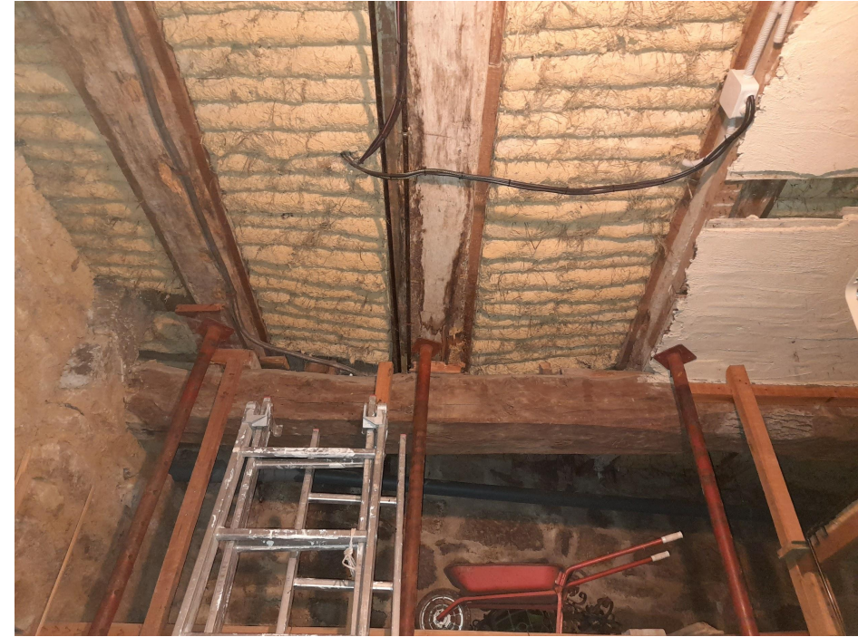
Caves/Rez-de-jardin : à assainir (reprise réseaux + terrassement + réfection du plancher) Sur photo de droite : étaieage provisoire des planchers suite à l'affaissement des poutres
