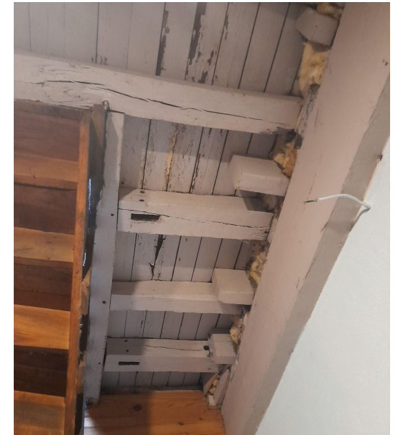
Laine de verre laissée apparente sur le palier du R+1
