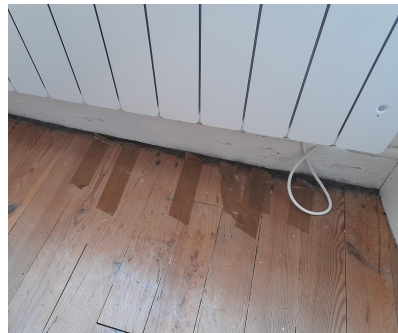
Défauts d'étanchéité du plancher et en pieds de murs suite aux mouvements de structure
