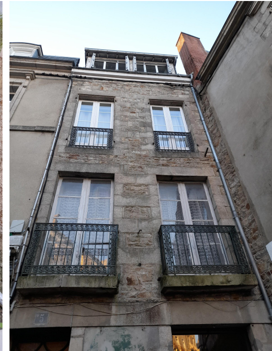
Façade sur rue : ravalement + menuiseries
